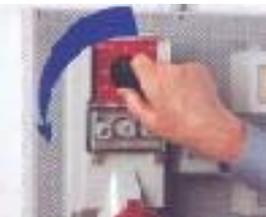
Togliere tensione al sezionatore di linea e scollegare il cavo d'alimentazione dell'attrezzatura
